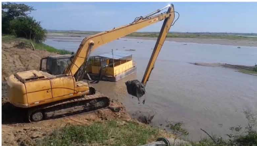
Cortesía Aqualia Trabajos de dragado.
