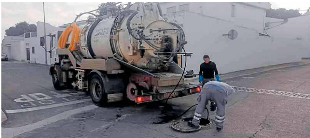
Tareas de limpieza de imbornales en Tous. LP
