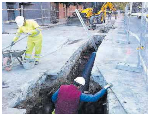
Obras de alcantarillado en el centro de València.
